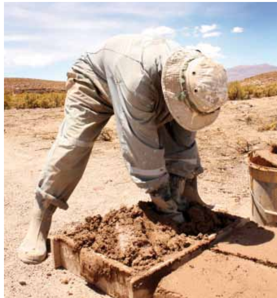
Técnica de construcción con adobe, Cancosa
