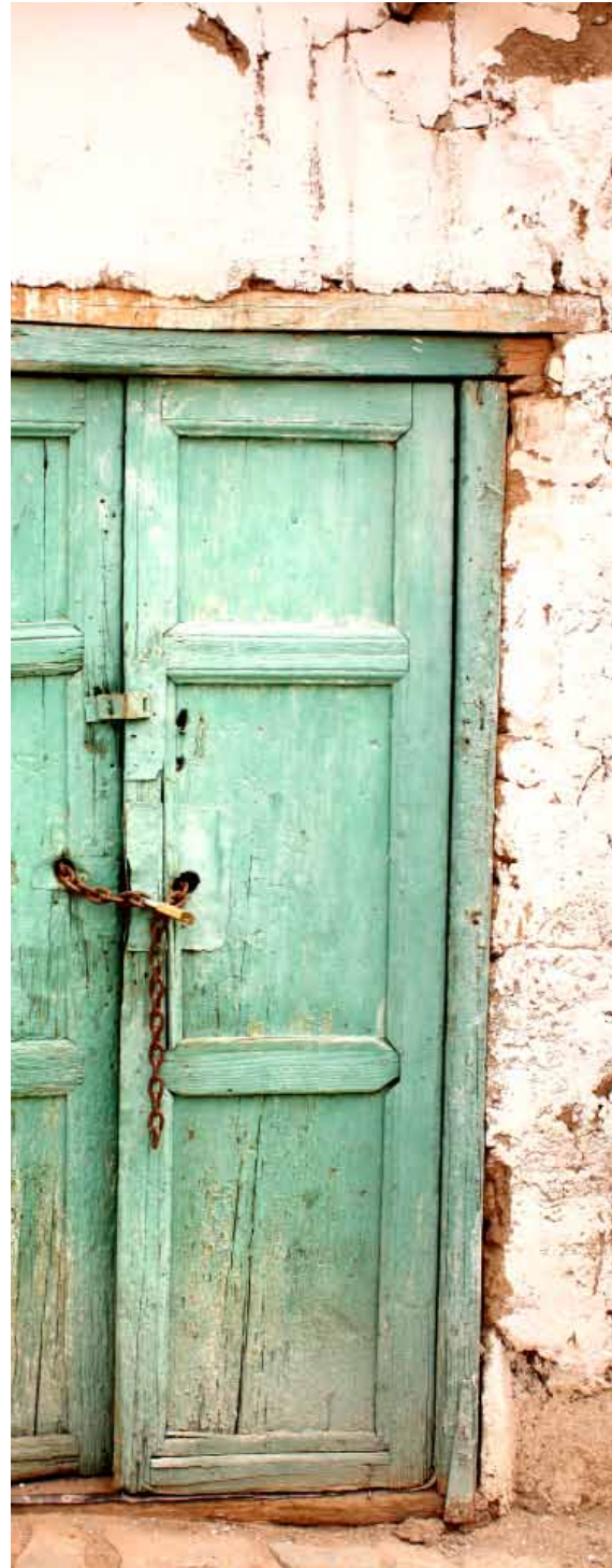
Arquitectura patrimonial de Huatacondo
