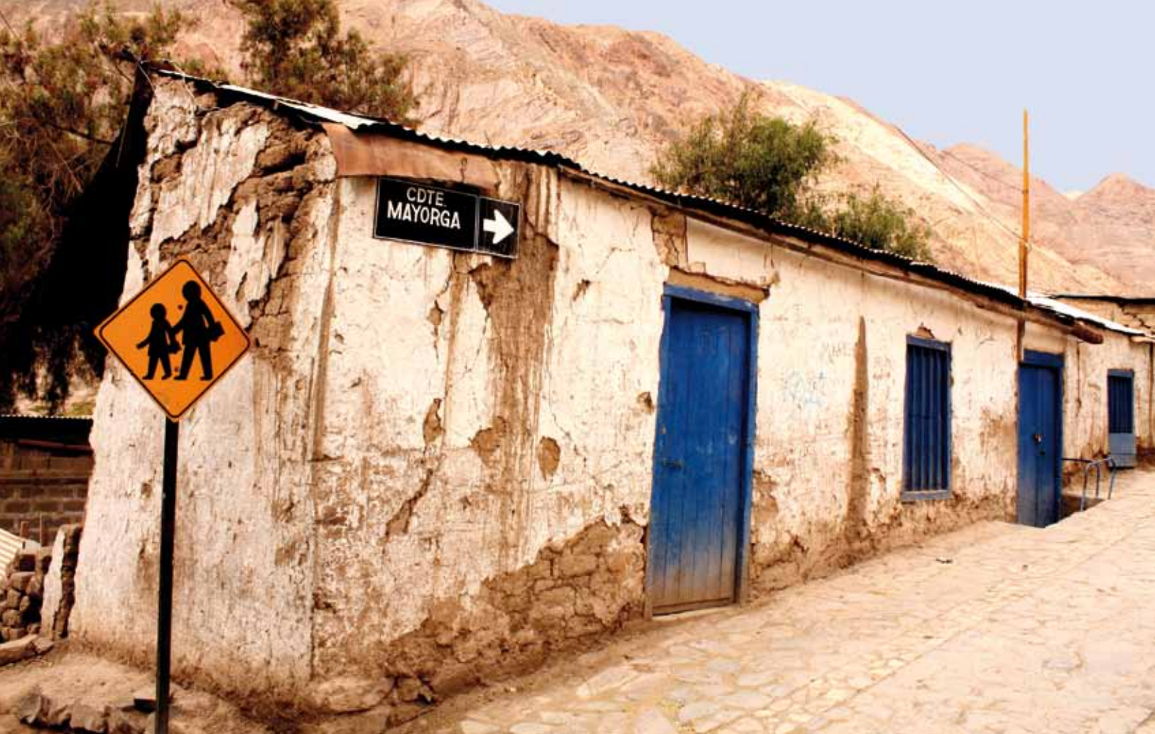
Arquitectura Patrimonial de Huatacondo
